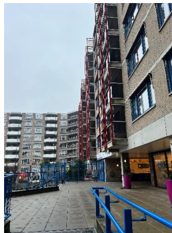
Afbeelding 10: Balkons aan pleinzijde, wooncomplex C. Foto: AiH.
