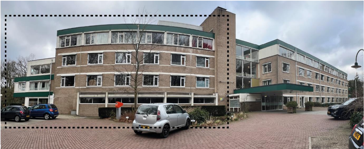
A: Gevelaanzicht Casus B in de zuidvleugel van het wooncomplex
